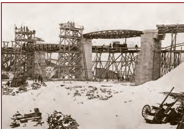
Brückenbau 1877 über den Mühlbach in Prien
