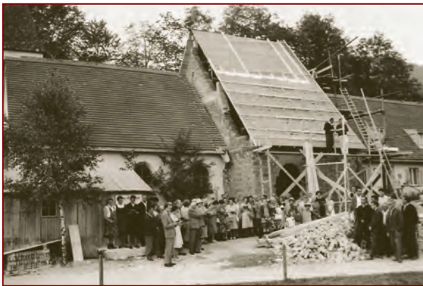
Richtfest für den zwischen alter Kirche und Pfarrhaus eingefügten Erweiterungsbau; Foto: Gemeindearchiv Aschau i.Ch.
